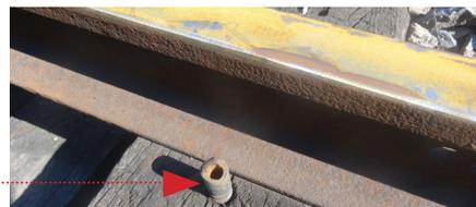
**SECURITE** : Il est recommandé de mettre en place des **Barres de maintien d'écartement** réf. **111** ou **112** sur les voies avec Tirefonds ou Boulons cassés. (Voir détails Fiche **1/5**)
